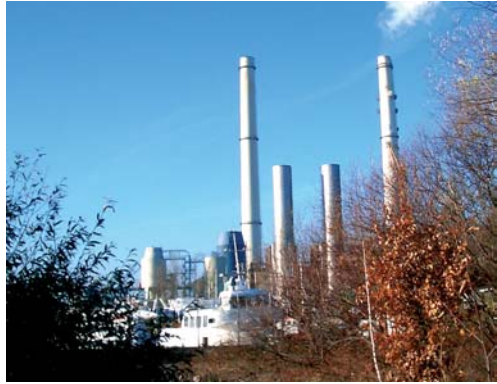
Heizkraftwerk der HEW
